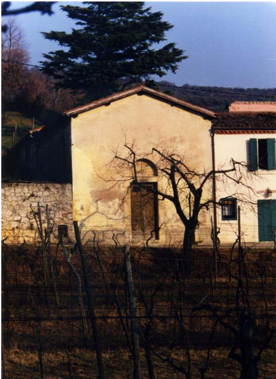
N. 31 – Marcellise. Villa Ferrari, oratorio di Santa Toscana: esterno.
