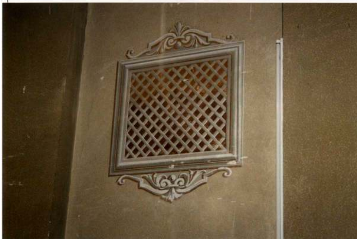
N. 35 – Chiesa parrocchiale di Marcellise. Coro: gelosia sul lato sinistro (in alto) e finta gelosia sul lato destro (in basso).
